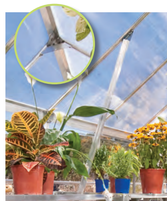
Speciálně vyztužená konstrukce
