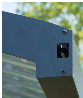
Okapy s odvodem vody
