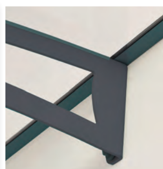
Pozinkované a lakované ocelové podpěry
