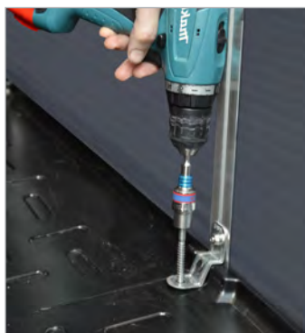
Kotvicí systém pro zvýšení stability
